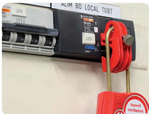
Les condamnateurs de disjoncteurs interdisent la manœuvre des organes de coupure modulaires. La mise en place est simple, avec ou sans outils, condamnable par un seul ou plusieurs cadenas.
